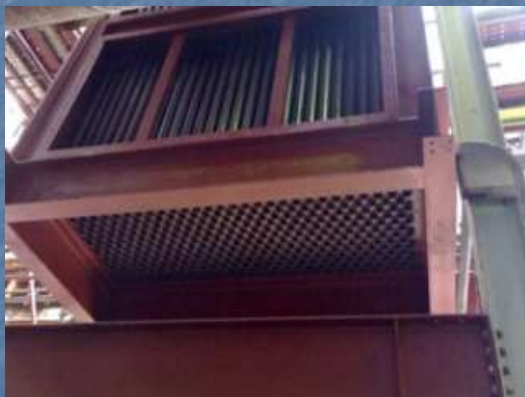
1 – trubkovnice, 2 – trubky, 3 – stěna tahu, 4 – obrátové přepážky
