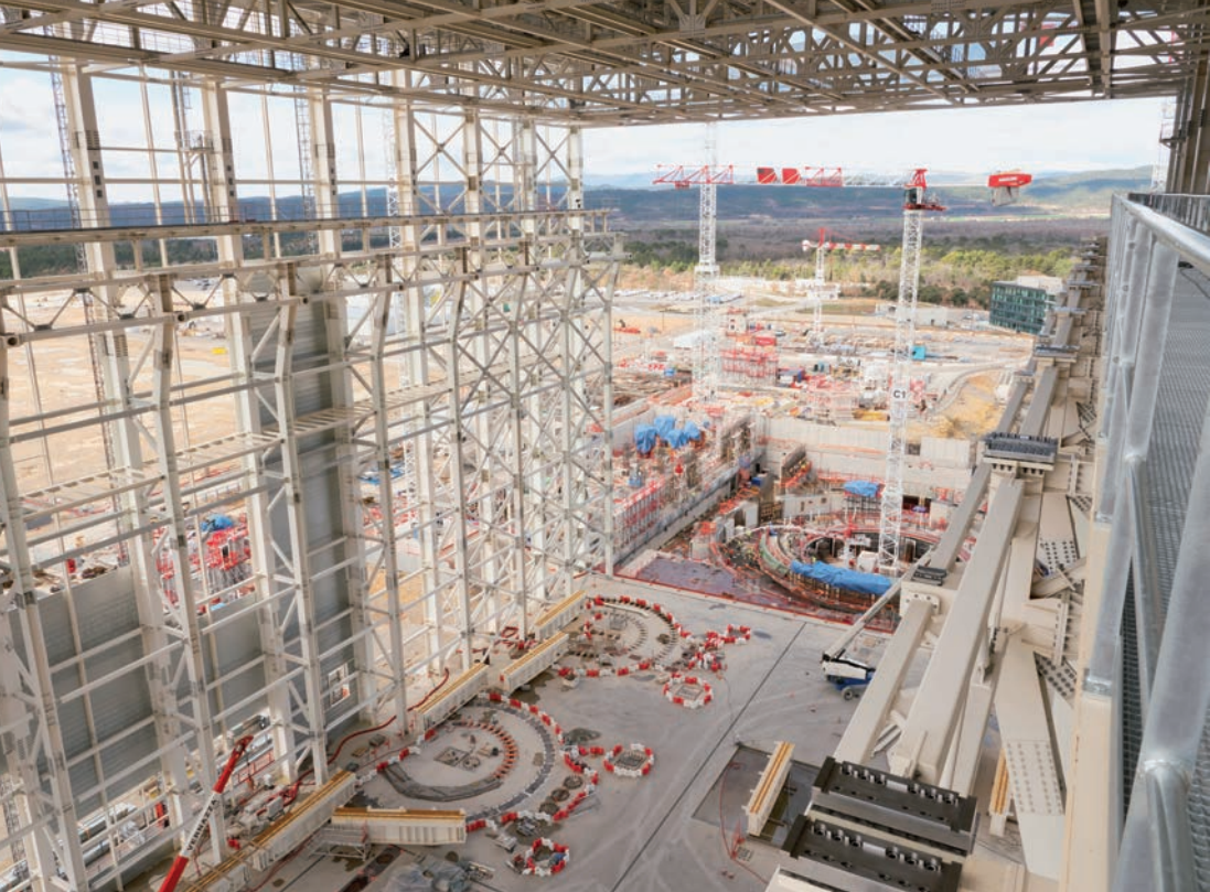
Staveniště ITER, březen 2016
